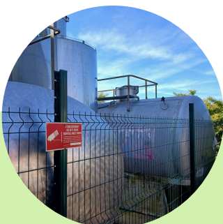
Sécurisation des cuves extérieures 2020
