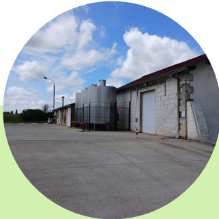
Chape de rétention pour effluents vitivini 2007
